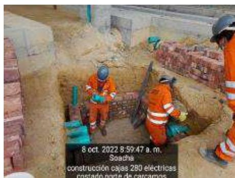
*Ilustración 41. Construcción de caja CS280 costado norte de cárcamos.*
