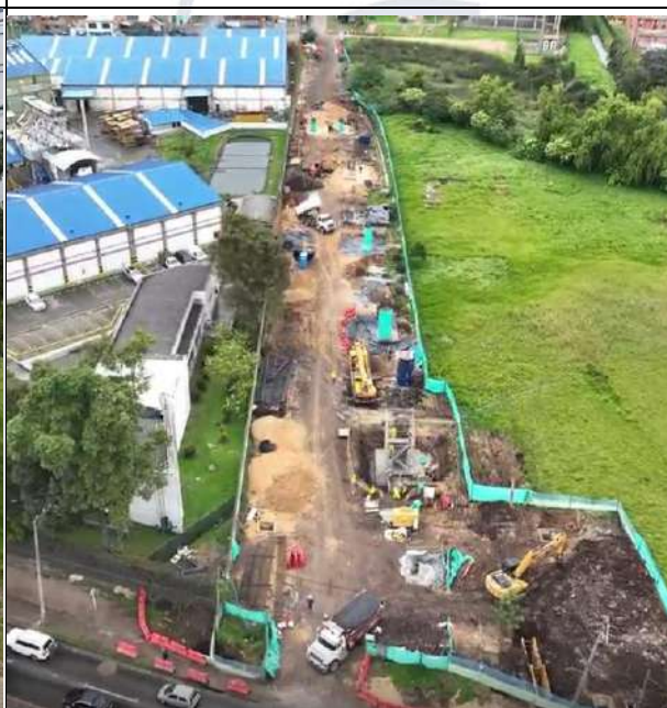
Estado actual - construcción pilotes, dados y pilas traslado de redes
