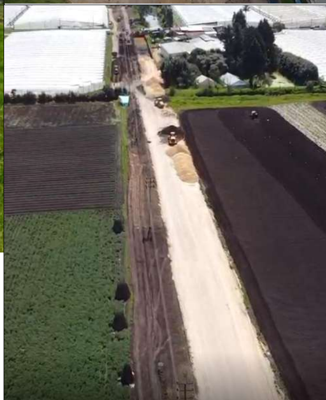
Estado actual - Avance de levantamiento de vía férrea y movimiento de tierras
